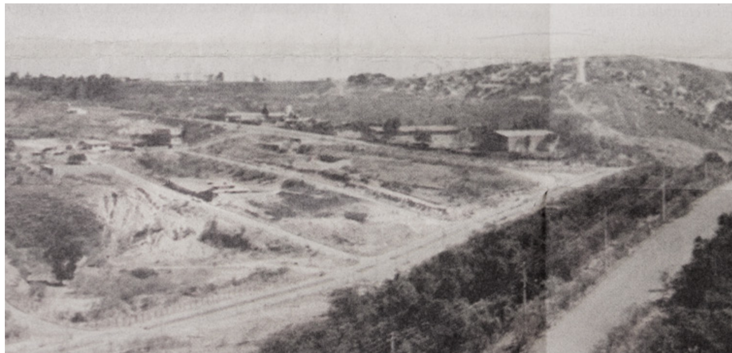
Obras de implantação do bairro Burity (década de 1980) - Fonte: Jornal Hoje em Dia - Cadernos Minas - Página 25 - Data: 23/04/1986 Construction of Burity (1980)
