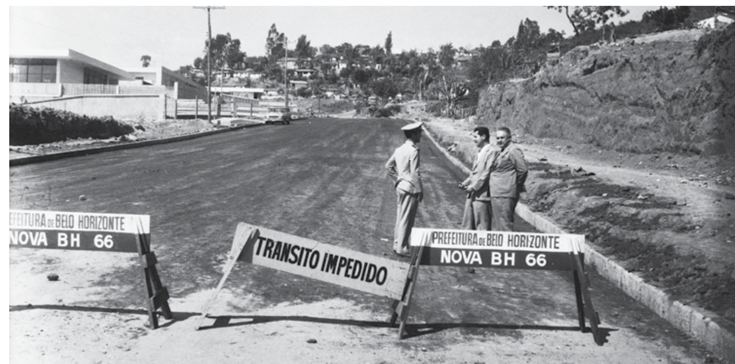
Prefeito Oswaldo Pieruccetti e sua equipe visita obras de implantação da avenida Raja Gabáglia (1966) Acervo do Arquivo Público da Cidade de Belo Horizonte / Fundação Municipal de Cultura Construction of Raja Gabáglia avenue and part of the downtown area of Belo Horizonte in the back (1966)
