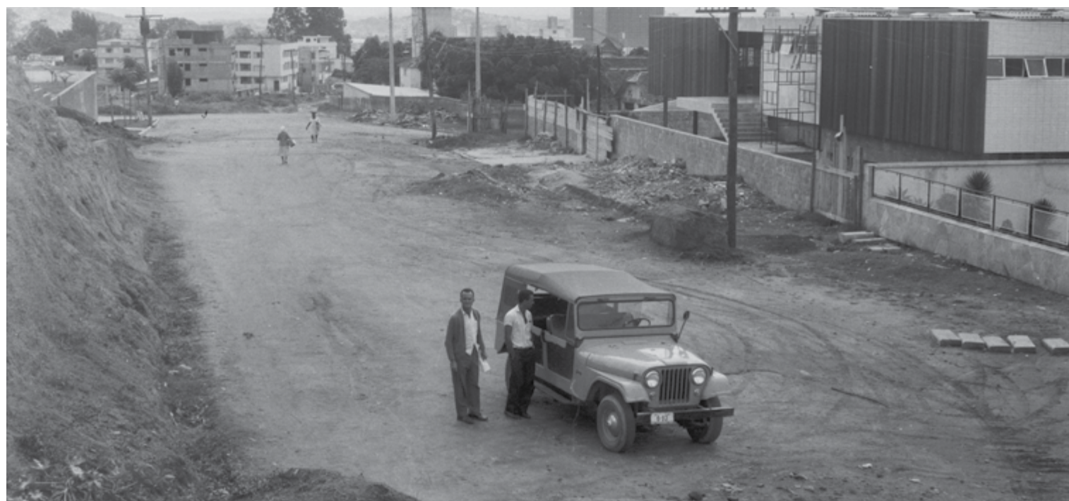
Implantação da Av. Raja Gabáglia, com vista de parte do Centro de Belo Horizonte ao fundo (1966) Construction of Raja Gabáglia avenue and part of the downtown area of Belo Horizonte in the back (1966)
